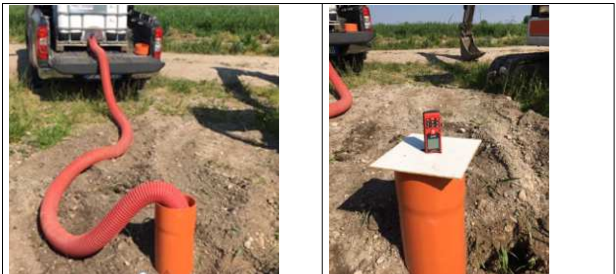
Figura 16 - Predisposizione del pozzetto di prova
