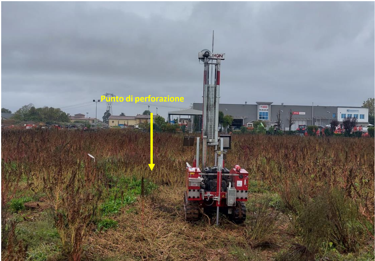
Figura 31: Stato dei luoghi (estratto da relazione geologica-geotecnica – postazione prova penetrometrica)
