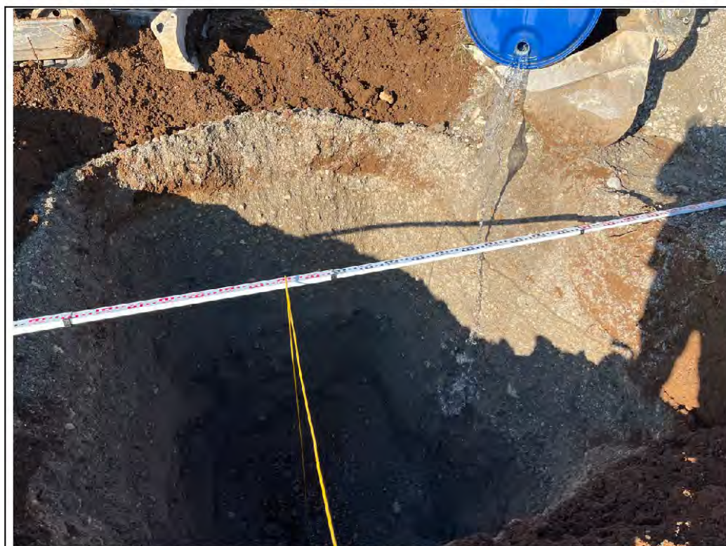
Figura 7: Esecuzione prova di permeabilità
